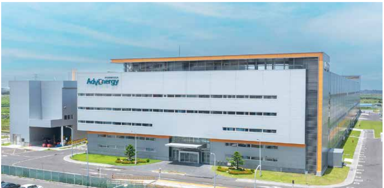
| 全台最大電芯廠 - 台塑尖端能源公司彰濱廠
